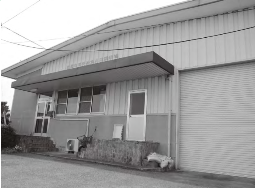
老朽化により廃止された武蔵学校給食共同調理場
