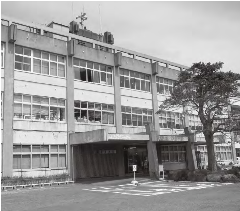
老朽化が進む現在の市役所本庁舎
